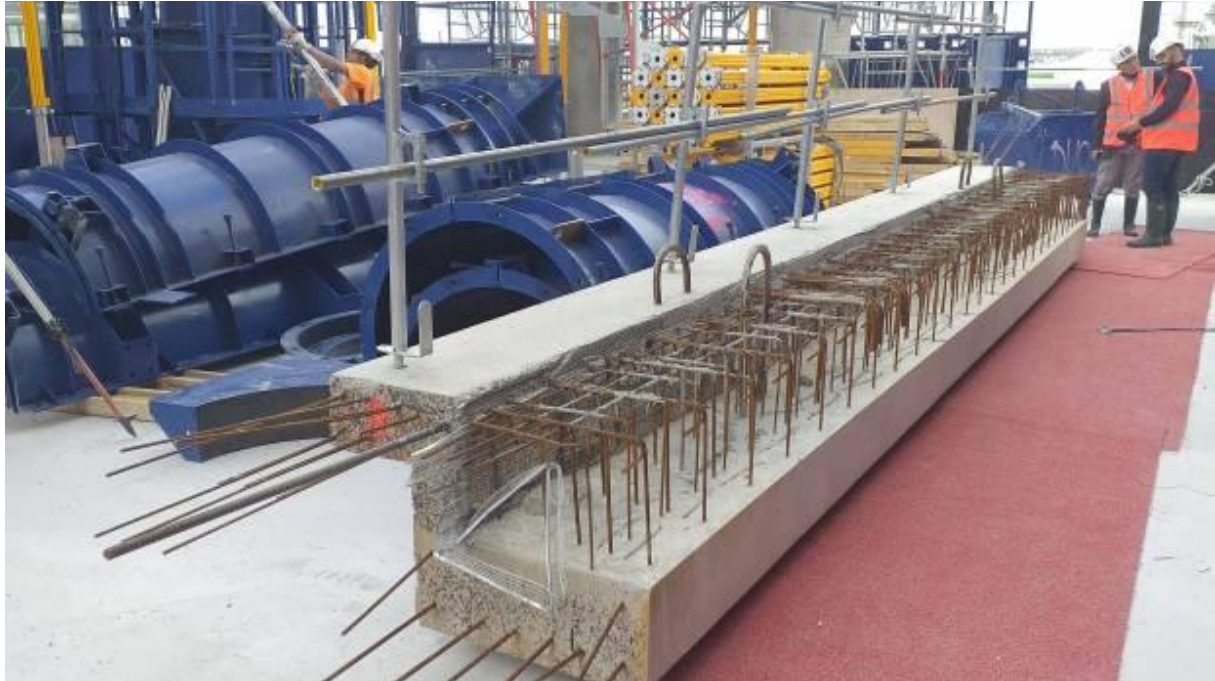
Poutre à béquet prête à être posée sur le chantier
